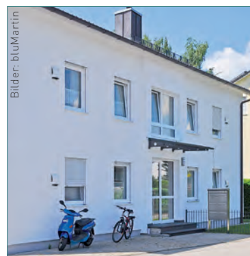
Dieses Mehrfamilienhaus in Mindelheim stammt aus den 1970er-Jahren und wurde 2011 im Zuge der energetischen Sanierung mit dem Lüftungssystem freeAir 100 ausgestattet. Seit der Sanierung ist der Heizenergieverbrauch um 47 % gesunken.
