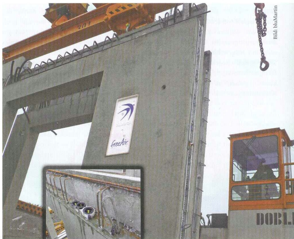
Im Beton-Look kommen die in Fertigteilen integrierten dezentralen Frischluftsysteme freeAir 100 mit Wärmerückgewinnung auf die Baustelle.
